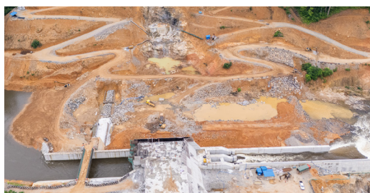
Derivation de la rivière Mbéi dans la vidange de fond du barrage
